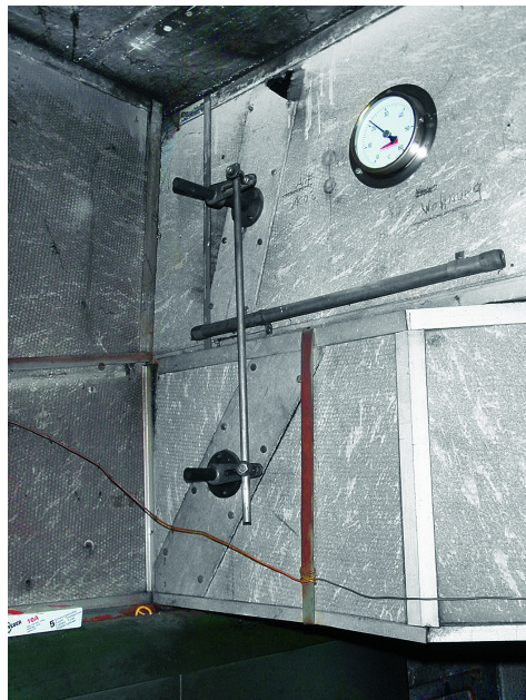
Canale di ventilazione in cemento amianto
