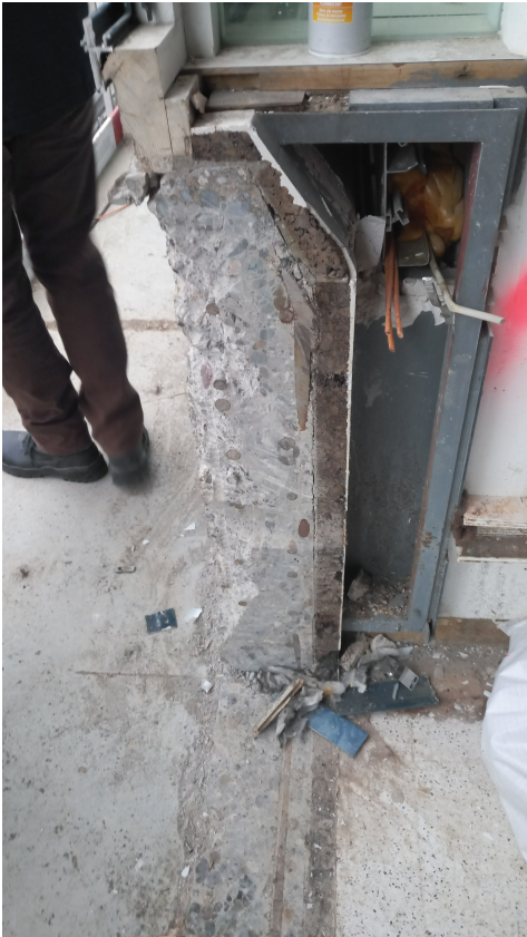
Sughero catramato in una facciata, SCS
