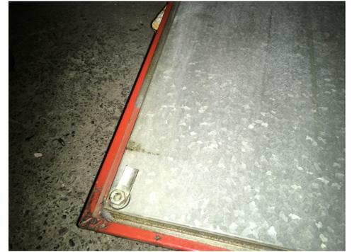
Schiuma contenente amianto nel coperchio di un monoblocco. (Foto: M. Hottarek, GEOTEST AG, 2020)
