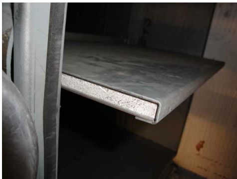
Serranda tagliafuoco con pala eseguita con pannelli leggeri, Carbotech
