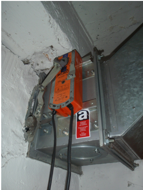
Serranda tagliafuoco. La pala della serranda si trova all'interno dell'apparecchio. (Foto: S. Schneebei)
