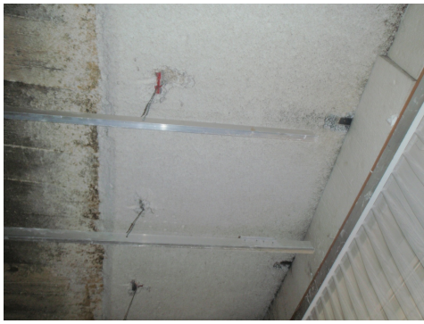
Amianto floccato utilizzato come isolamento termico su una soletta in calcestruzzo.
