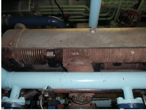
Tessuto di amianto utilizzato come isolamento termico attorno al tubo di scarico di un generatore diesel.
