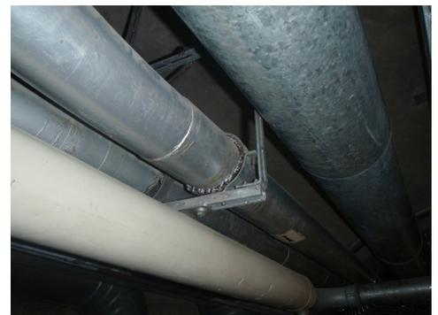
Nastro di amianto applicato sul supporto di una tubazione.
