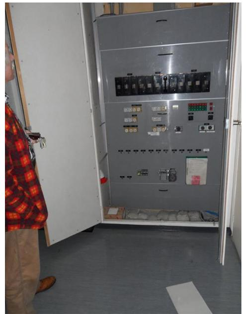
Cuscini di amianto e pannello leggero contenuti amianto sul lato interno della porta di un quadro elettrico.
