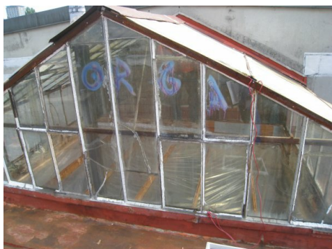
Tetto vetrato munito di stucco per finestre contenente amianto.
