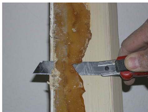
Rimozione del mastice per battuta, Suva
