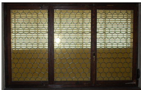
Finestre con ornamenti di piombo contenenti amianto nello stucco. Gli artisti vetrai o hanno miscelato lo stucco da sé, nel qual caso non contiene amianto, oppure hanno usato prodotti pronti all'uso, che hanno diluito con olio di lino. In questo caso, anche lo stucco per finestre negli ornamenti di piombo può contenere amianto. (Foto: Esperto IBH Markus Durrer)
