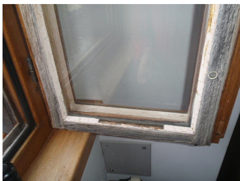
Stucco per finestre contenente amianto. Anche se si stacca, non rappresenta un pericolo per la salute dei residenti.
