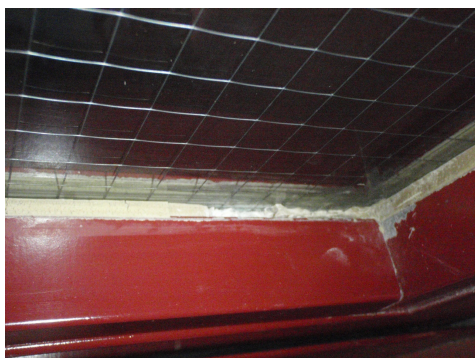
Porta tagliafuoco munita di una corda di amianto sotto lo stucco per finestre.
