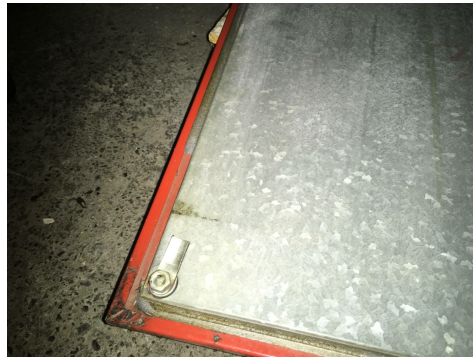
Mousse amiantée comme joint d'étanchéité pour Monobloc, Geotest
