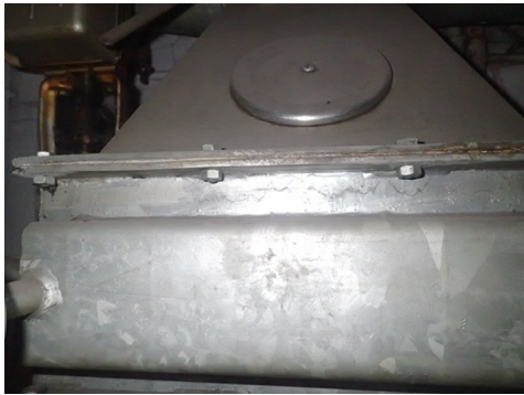
Etanchéité bitumineuse dans gaine de ventilation. Photo: C. Campoarmor, Arcadis Schweiz AG
