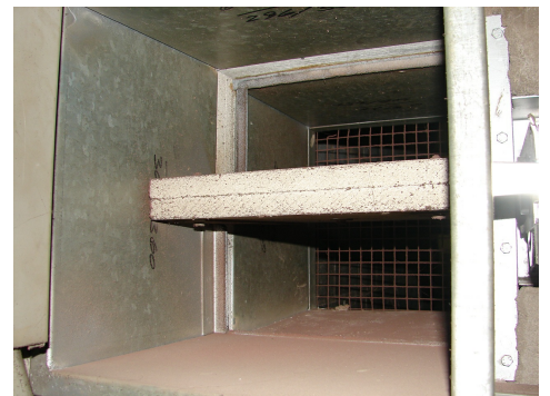
Clapet coupe-feu avec joint d'étanchéité en Litaflex, Carbotech
