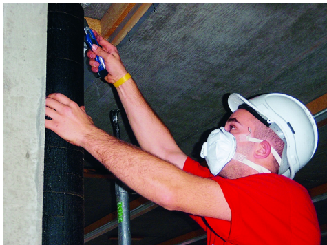
Entfernung der Leitungsdaämmung mit asbesthaltigem Bitumenanstrich, Suva
