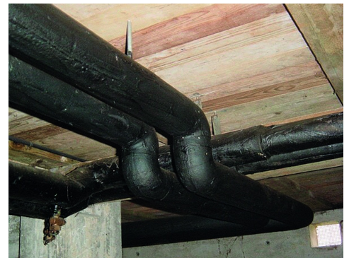
Bituminoöser Anstrich auf Leitungsdaämmung, Suva
