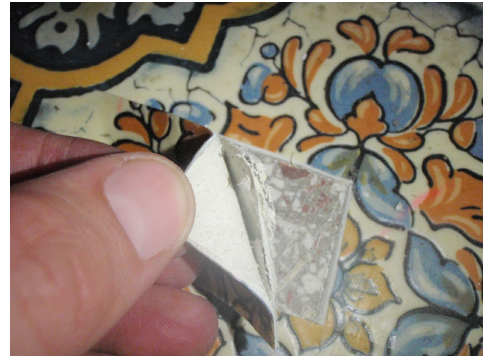
Mehrschichtiger Bodenbelag. Die untere Schicht ist von der Konsistenz her wie Karton und löst sich manchmal spontan ab
