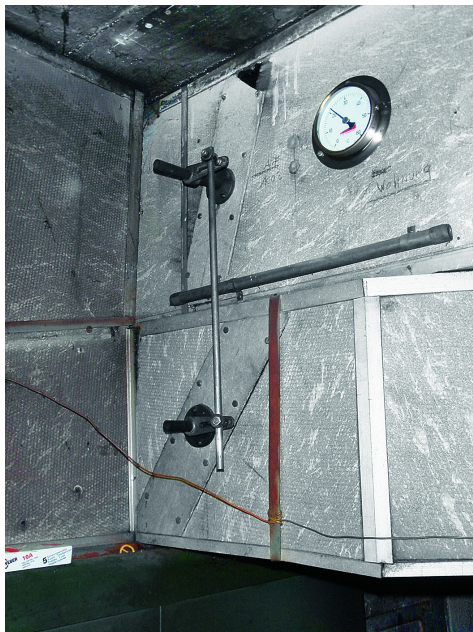
Lüftungskanal aus Asbestzement
