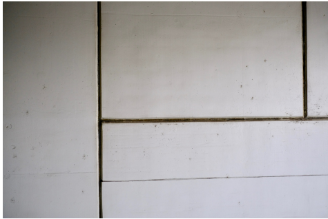
Fugendichtungsmasse, Gebäudediagnostik Siegwart
