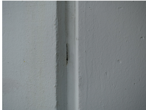
Fugendichtungsmasse, Gebäudediagnostik Siegwart
