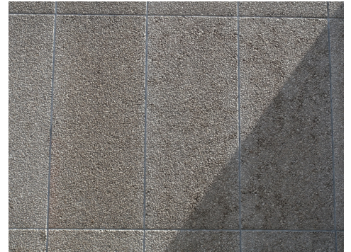
Fugendichtungsmasse Waschbeton, Gebäudediagnostik Siegwart
