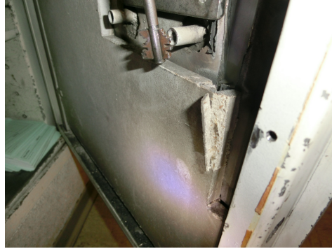
Asbesthaltige Leichtbauplatte LAP in Tresor. Diese lassen sich meist relativ einfach im offenen Zustand durch Abschrauben der inneren Blende kontrollieren. Ebenfalls können Proben mit einem spitzen Werkzeug aus den Tablarlöchern entnommen werden. Photo: Ecosens AG, Wallisellen.
