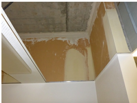
Spachtelmasse mit Asbest. Einbau in den 70er-Jahren. Photo Carbotech AG.
