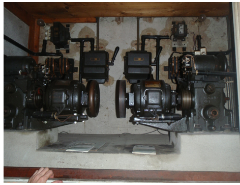
Motor von einem Speiseaufzug in einem Restaurant. Die Bremsbeläge sind potentiell asbesthaltig.
