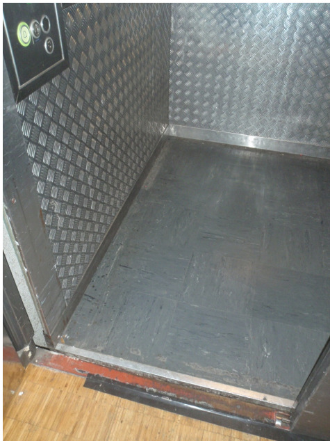
Warenlift mit Floor-Flex-Bodenbelag (hier ohne Asbest).
