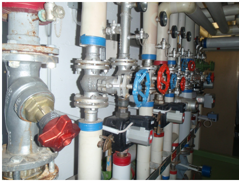
Alte IT-Dichtungen enthalten sehr oft Asbest.
