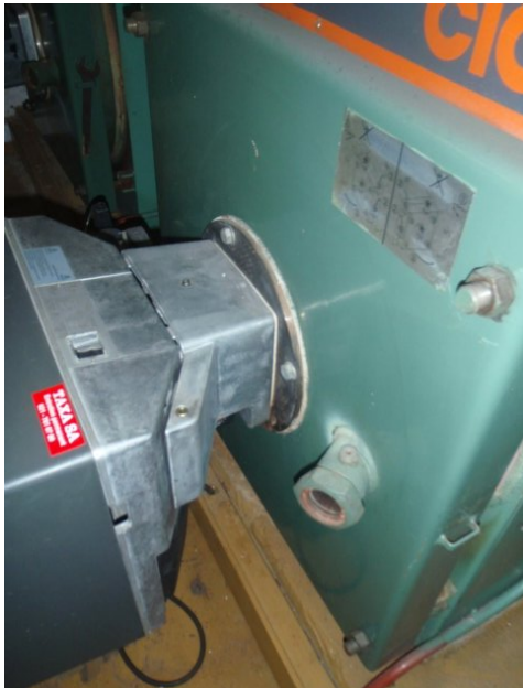
Dichtung am Brenner einer Heizung. Hier handelt es sich um ein schwachgebundenes Material.
