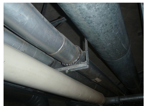
Photo Asbestband bei Rohrhalterung
