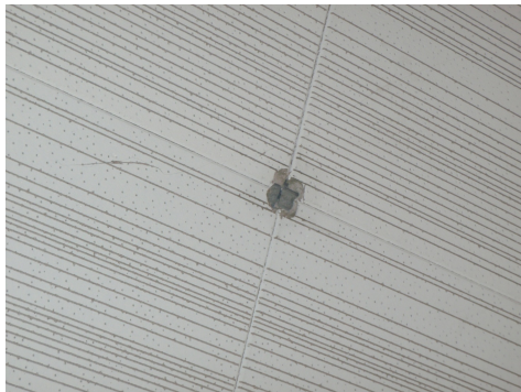
Akustik-Deckenplatten nach Beprobung
