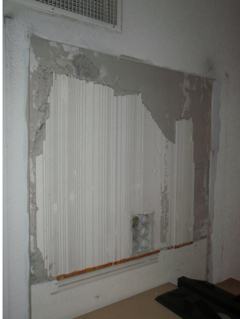
Akustik-Isolation an Wand, bereits teilweise abgerissen. Das Material ist innen in der Regel grau.
