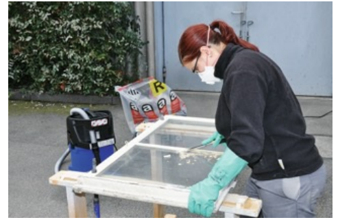
Entfernung eines asbesthaltigen Kitts mit Handwerkzeugen, Suva
