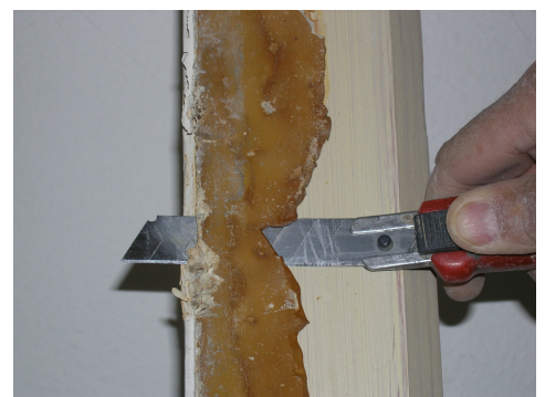
Anschlagkitt entfernen, Suva
